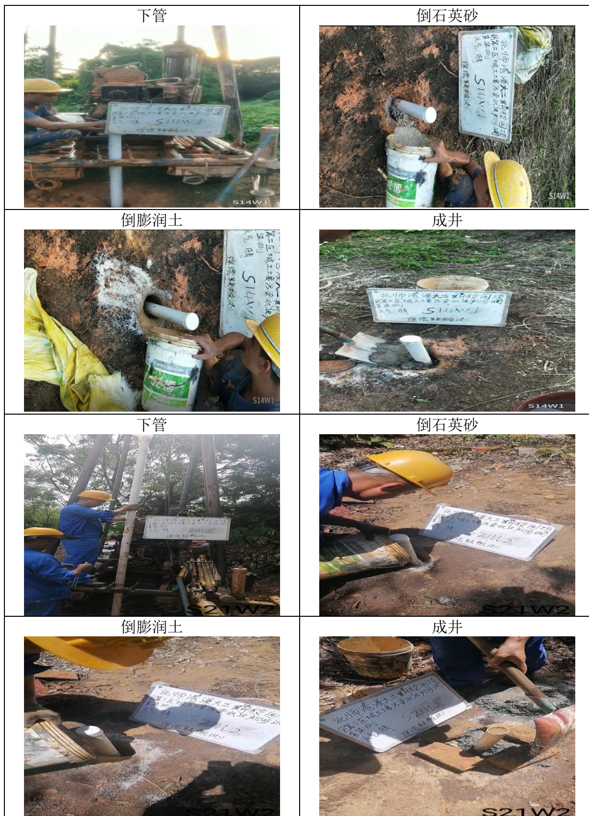
图 4.2-6 地下水检测井建井成井图
