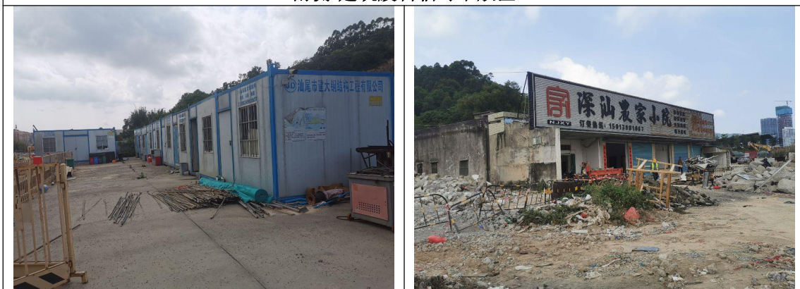
南侧-施工营地
