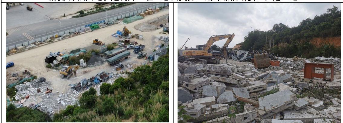
南侧-建筑废料临时堆放区
