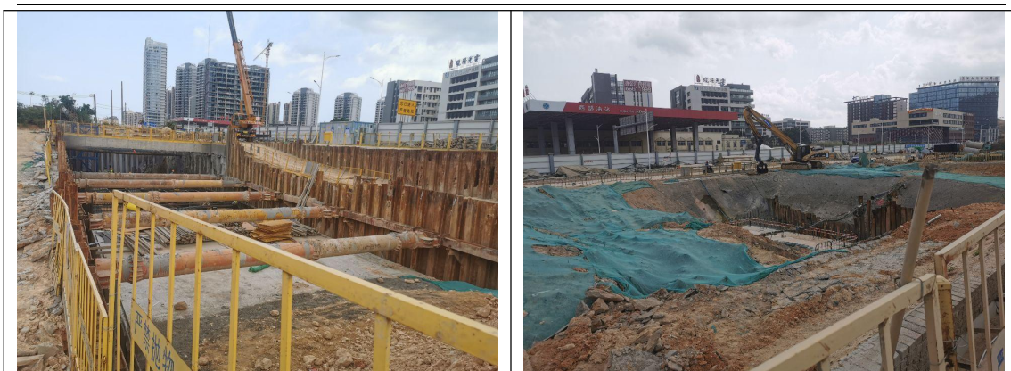
南侧-深汕大道扩建提升工程（惠汕交界至鹅埠加油站段）在建工地
