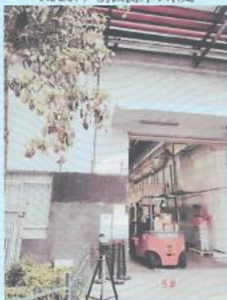
N5C08 厂房东侧外 1 米处
