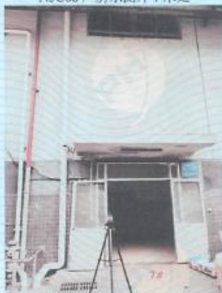
N7C08 厂房北侧外 1 米处
