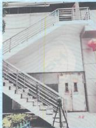
N4C07 厂房北侧外 1 米处
