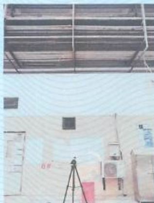
N8C09 厂房东侧外 1 米处
