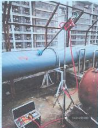
G17 喷砂废气 DA012 处理前检测口
