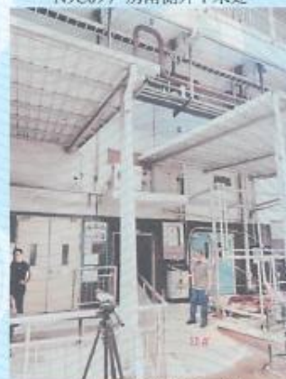
N11C09 厂房北侧外 1 米处
